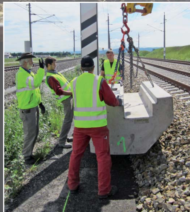
Setzen der Betonsockelelemente
