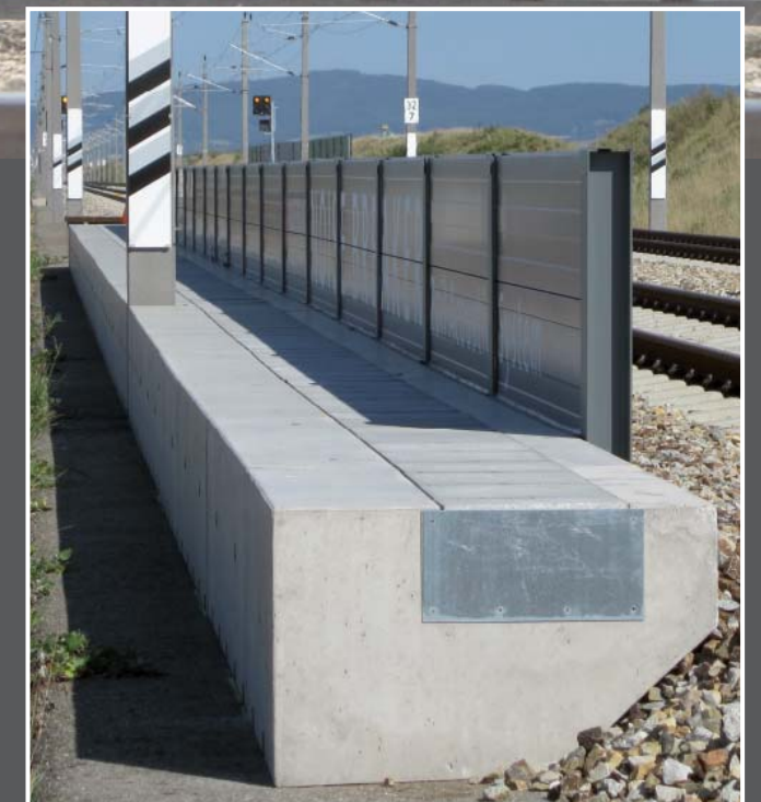
Noise Breaker nach der Montage
