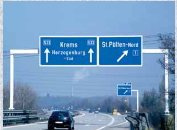
Schilderbrücken und Kragkonstruktionen
