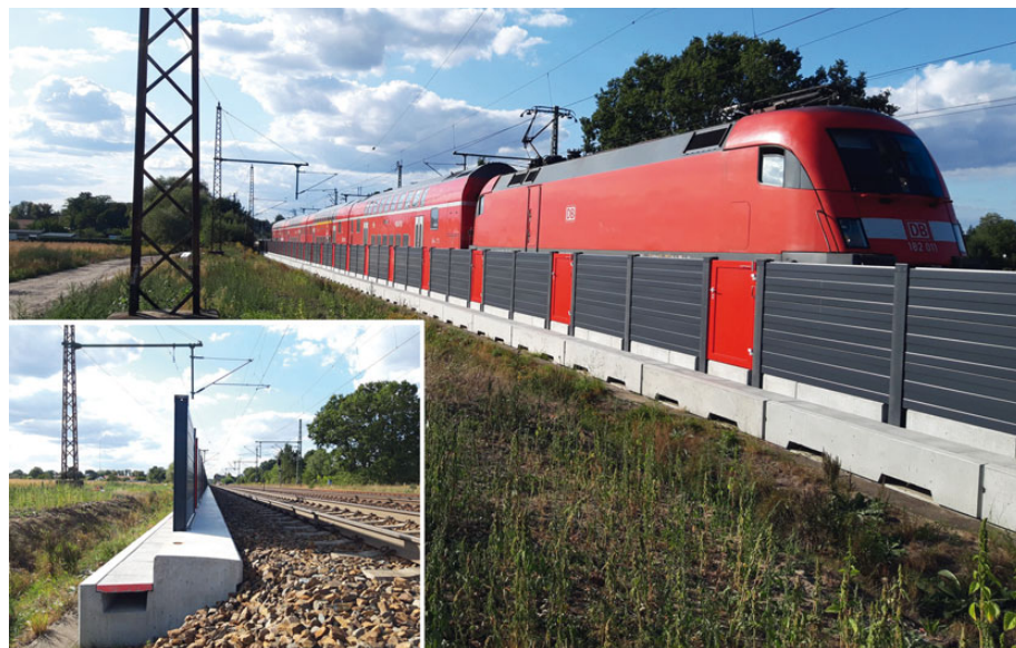
Abb. 1: Noise Breaker im eingebauten Zustand
