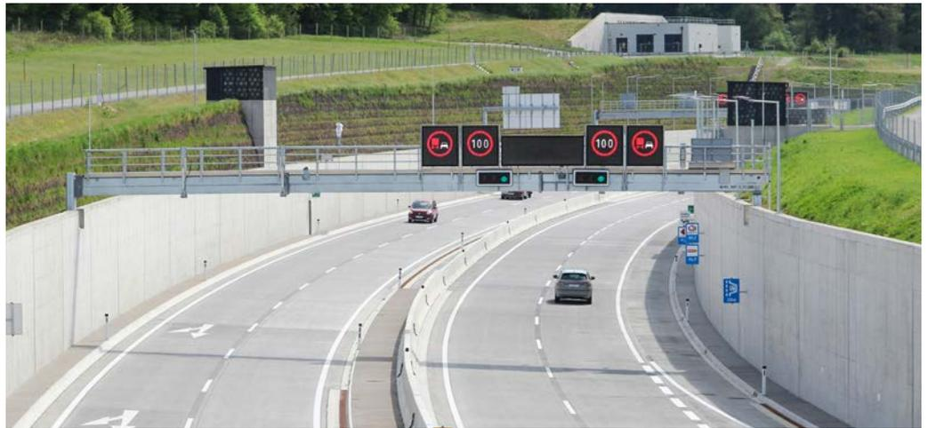
Das Wannbauwerk erforderte Sonderkonstruktionen für die Verkehrszeichen-Brücken.
